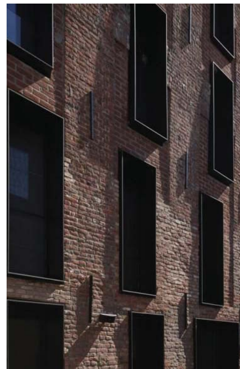
stålramme tegner vindueshul
