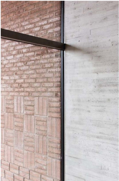
møde mellem teglvæg og betolvæg
