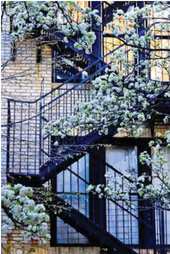
stålaptering, udvendige trapper
