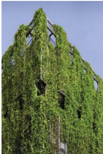
grønne haver og facade
